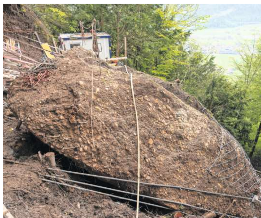
Oberhalb von Oberarth, im Härzigwald, musste dieser Felsblock gesichert werden. Er wird jetzt zerkleinert.
