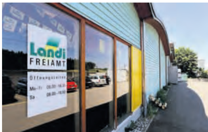
An dieser Stelle drangen die Einbrecher in die Landi-Filiale ein.
